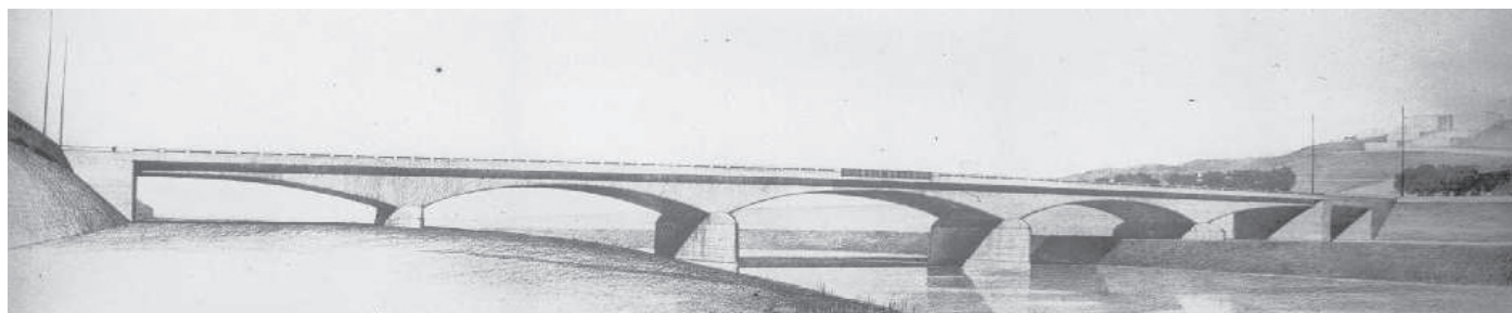
ASR, Ufficio Speciale del Tevere e dell'Agro Romano, Il versamento, lastre, lotto 9, scatola 227, ponte sul Tevere alla Magliana, appalto concorso, Proposta dell'impresa Allegri, prospettiva del ponte, 1938
